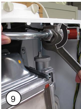
9. Lösen Sie die Überwurfmutter der Gasarmatur;
