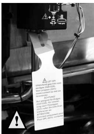
**Alle gasführenden Leitungen und Verschraubungen sind auf Dichtigkeit zu überprüft (mittels Lecksuchspray).**
